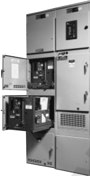
DS Switchgear Assembly
