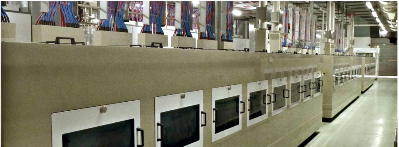
Eine horizontale Metallisierungsanlage, mit der Microvias auf einem HDI-Produkt mit Kupfer gefüllt werden.
