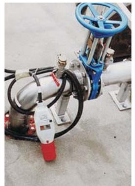
Alle NOLTA Motorschutzstecker sind standardmäßig mit einem Überstromschutzschalter und einem Ein/Aus- oder Hand /Automatik-Schalter ausgestattet.
