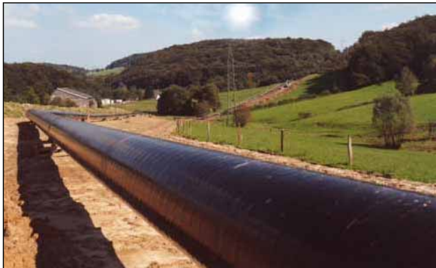
油气管线泄漏监测
