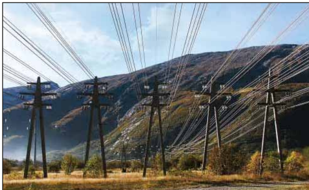
电力架空线监测
