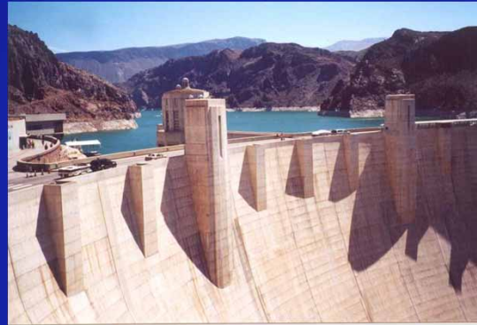
Мониторинг дамб, плотин и насыпей
