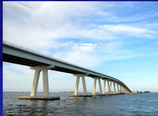
桥梁和建筑物的监测
