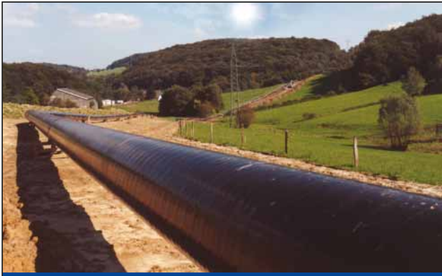
油气管线泄漏监测
