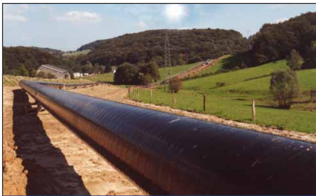
油气管线泄漏监测
