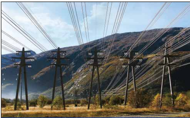
电力架空线监测
