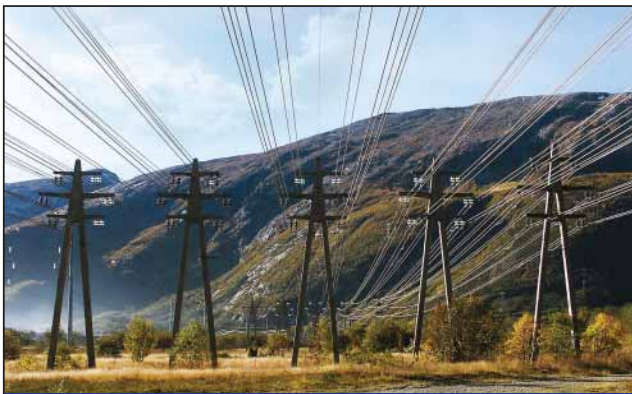
Мониторинг линии электропередач
