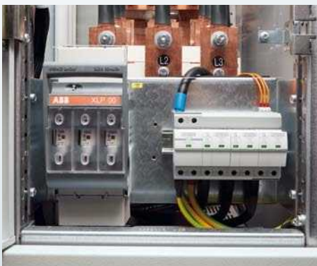
FLASHTRAB-SEC-T1+T2 im Einsatz
