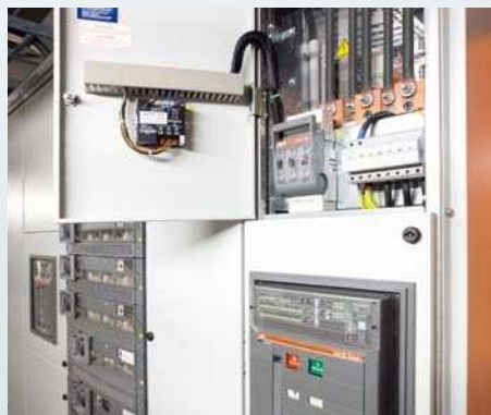
Niederspannungseinspeisung
