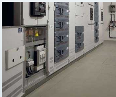
Niederspannungseinspeisung
