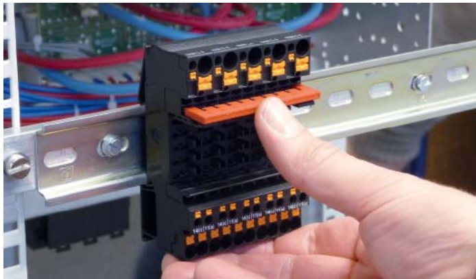
1 Steckbrücke für die Sammeleinspeisung einschieben.
