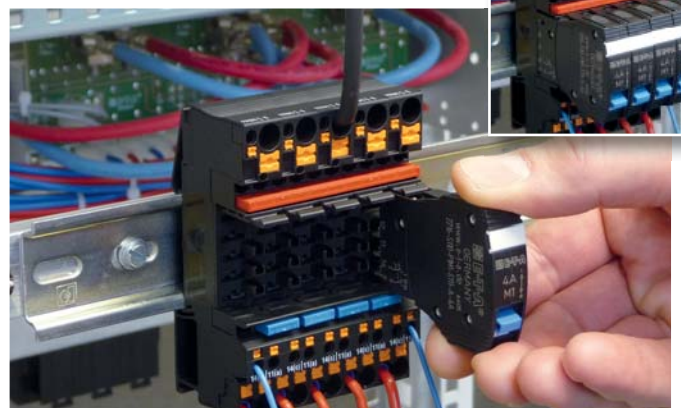
6 Schutzschalter 2216-S aufstecken. Fertig!
