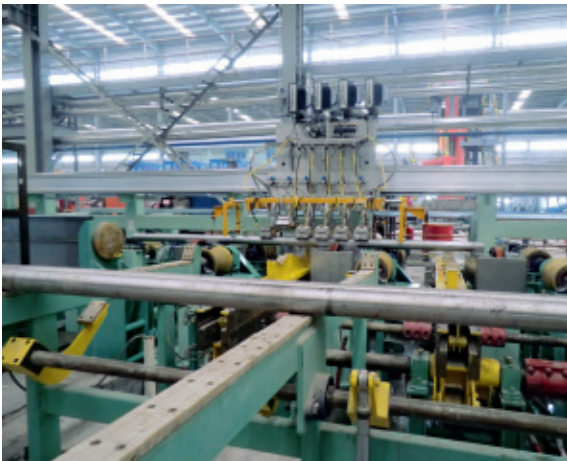
ET und UT Rohrprüfanlage
