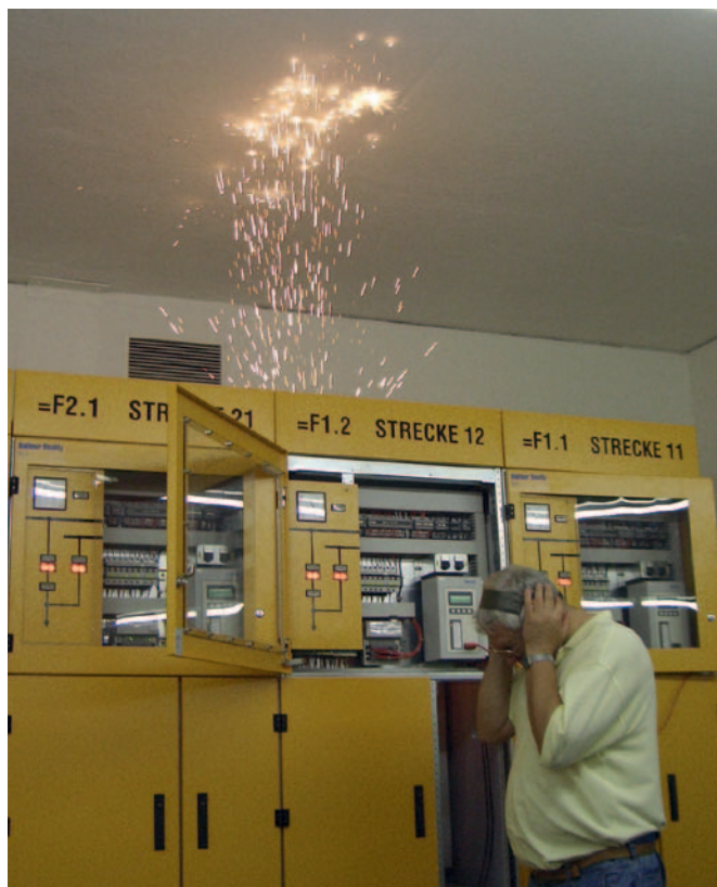
Kurzschlussmessung im Mittelspannungsnetz.
