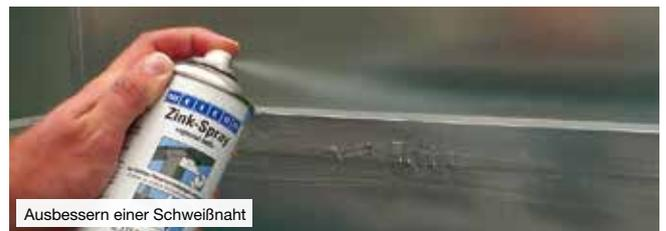
Ausbessern einer Schweißnaht
