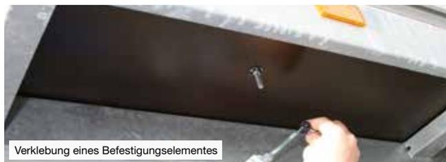
Verklebung eines Befestigungselementes
