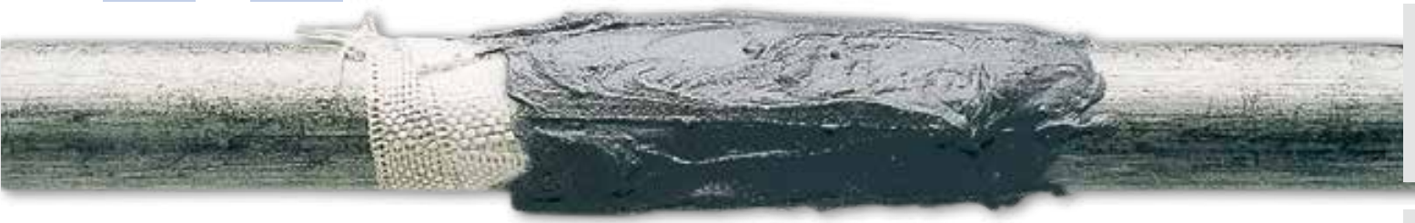
Schnelle Reparatur einer Wasserleitung
